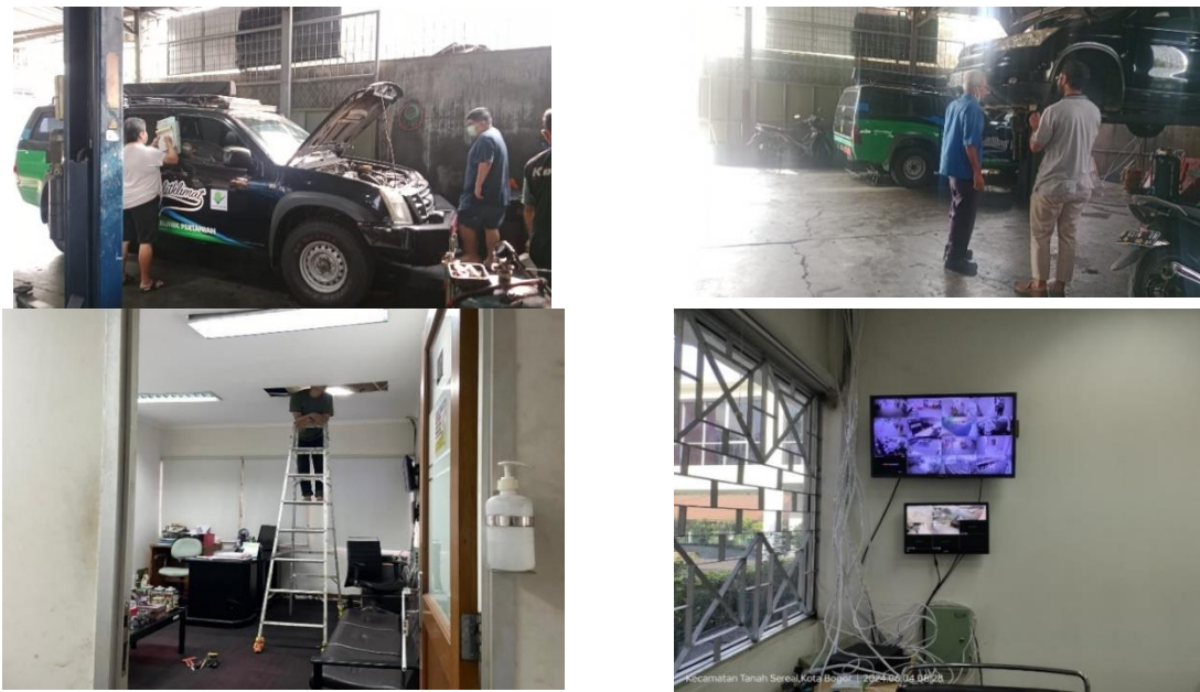
Gambar 64. Perawatan kendaraan dan pemasangan CCTV
